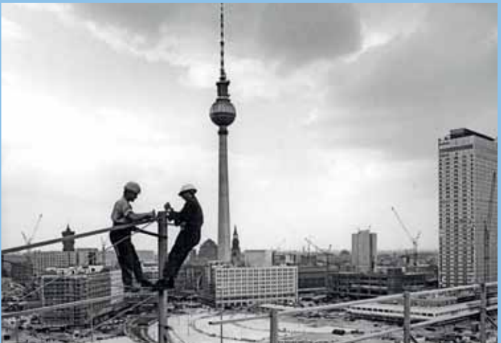
Bauarbeiter bei Montagearbeiten an der Leuchtschrift auf dem „Haus der Statistik“, Ost-Berlin, 13. August 1969 © Bundesarchiv (183-Ho813-0026-001) | Foto: Eva Brüggmann
